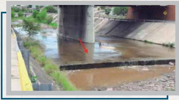
**Figura 3.** Recubrimiento de concreto alrededor del muelle (Moncada *et al.*, 2007).
