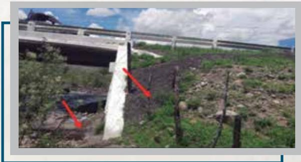
**Figura 4.** Recubrimiento asfáltico en el ala de estribo (Ettema *et al.*, 2003).
