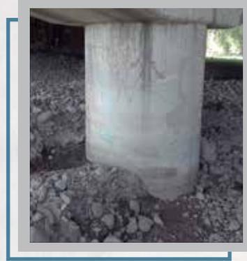
**Figura 1.** Se muestra el inicio de la socavación en una columna.
