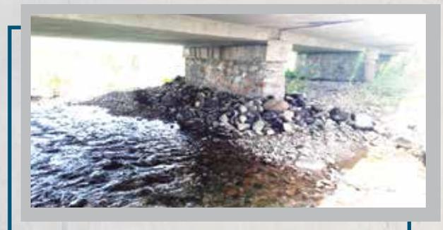
**Figura 2.** Colocación de piedras alrededor del soporte de un puente (Moncada *et al.*, 2007).
