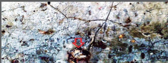
Figura 1. Agrietamientos en el concreto y evidencia del gel producto de la RAA.
