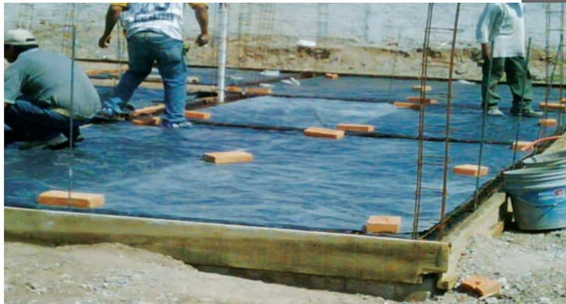
**Figura 2.-** Implementación de sellado y tubería de ventilación en nueva vivienda.
